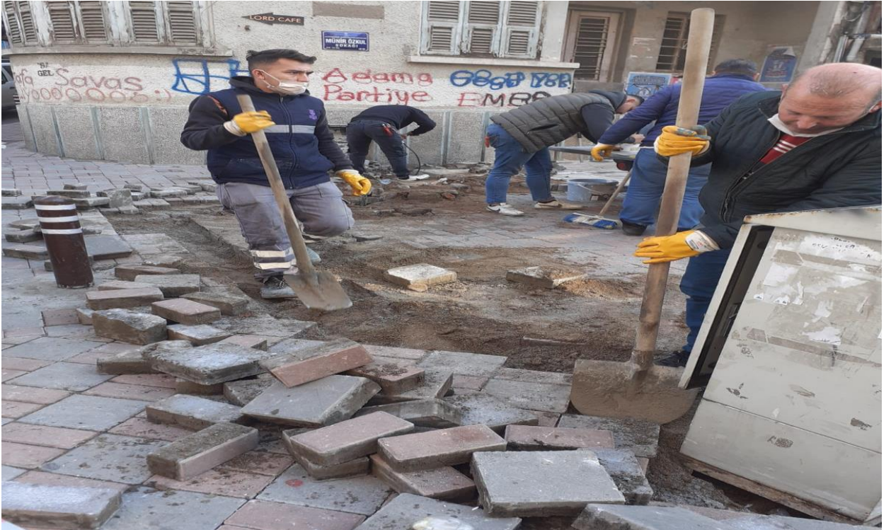
Hidrolik Bariyer Taşıma Uygulaması
